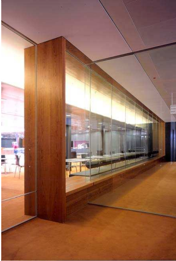
Blick aus dem Flur durch die HOBA 9 SYSTEMGLAS®-wand F90 in den Innenbereich des e-market-place
